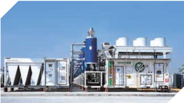
樂能國際專注提供含有機朗肯循環(「ORC」)技術以轉換廢熱至電能之高能效方案，適用於燃氣和燃柴油電站、油氣工業、酒店、醫院、船舶電力、地熱能、生物質氣體和堆填沼氣等不同範疇。樂能國際獲授權使用德國Orcan Energy AG之ORC技術、專利和品牌。我們與樂能國際之間能產生龐大的協同效應，因為我們可以把ORC技術應用到我們的分布式電站以提高能源效益。例如，我們為Myingyan II項目的發電站安裝了樂能國際的模塊式ORC系統，成功提高項目的能源效益。
